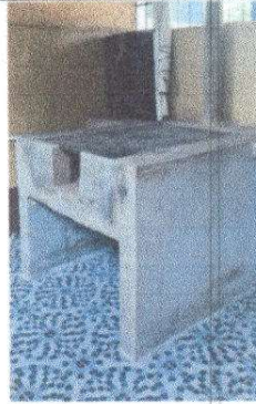
Foto 8: Mantenimiento a estufa rural. Sustitución de plancha de metal de 3 hornillas en área de cocina.
