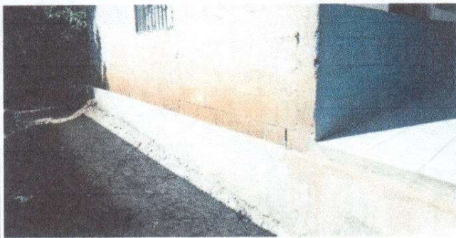
Foto 9: Reparación de cuneta de concreto
